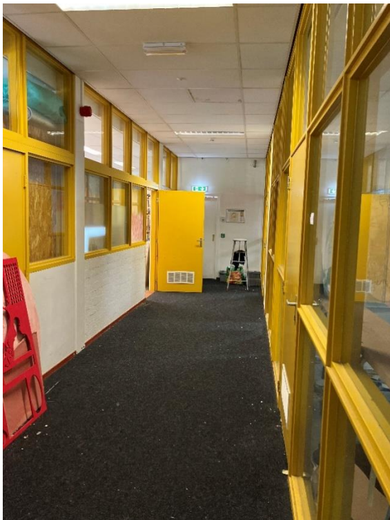
Gang naar atelier op de eerste verdieping
