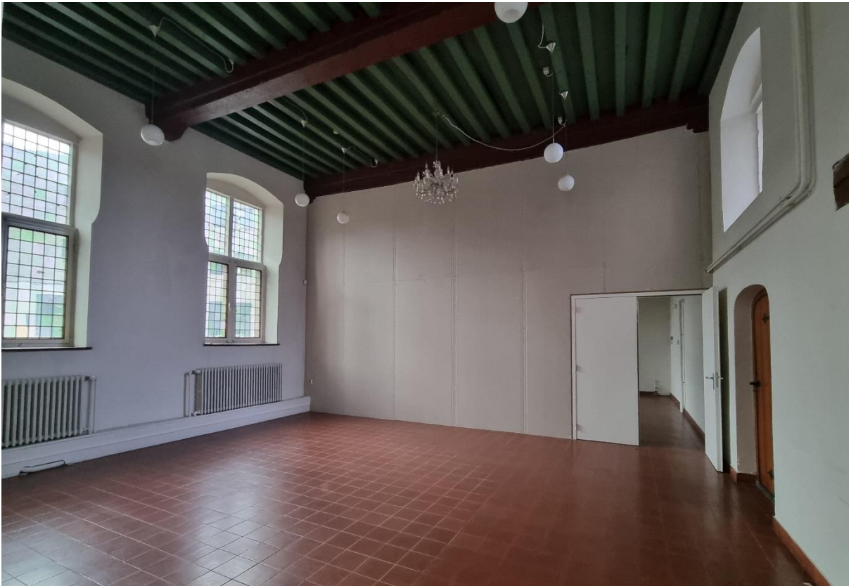
Ruimte 0.07 voorste deel
