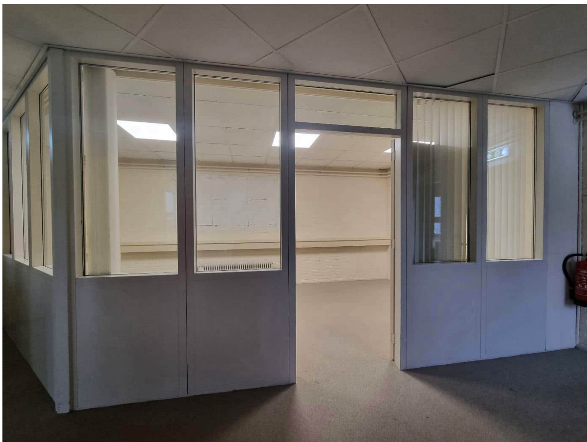
Ruimte 3.08 gezien vanaf de gang
