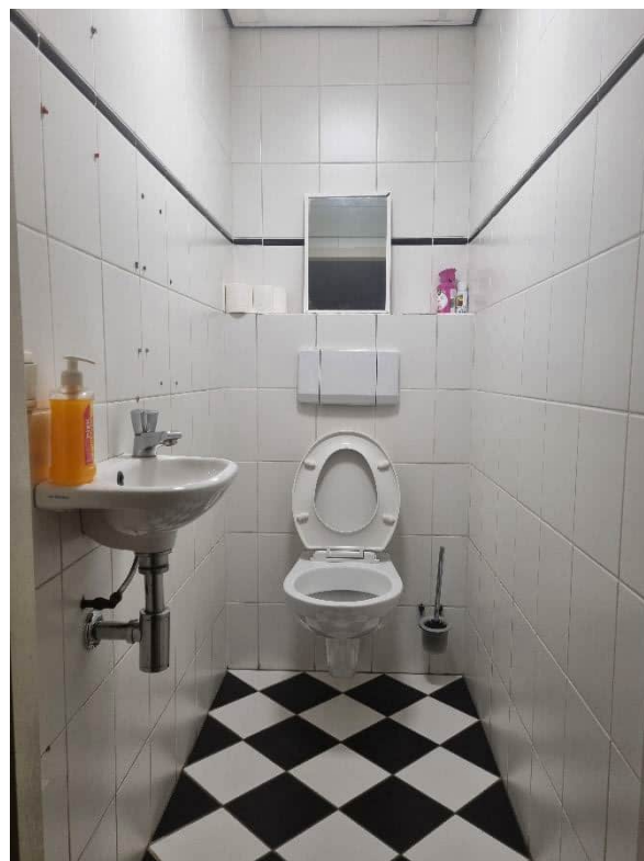
Toilet rechts, derde verdieping
