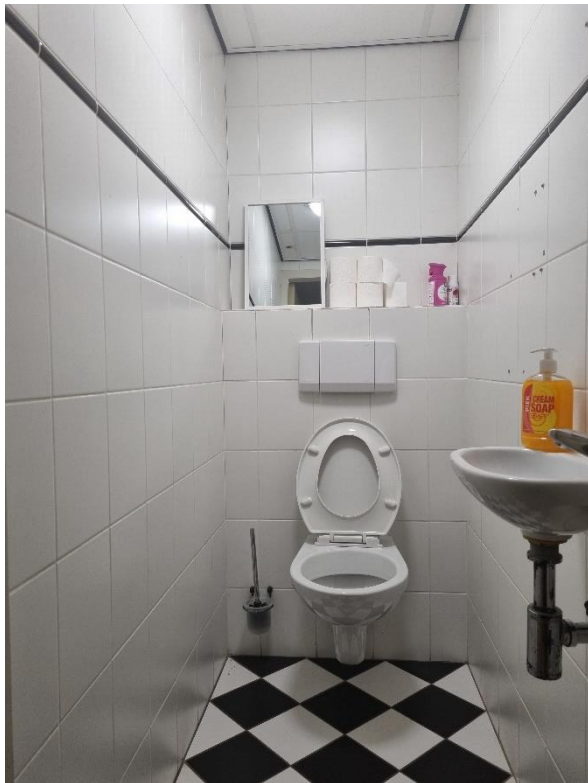
Toilet links, derde verdieping
