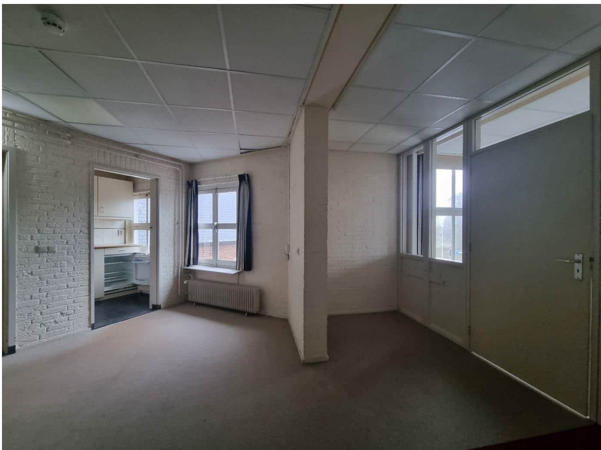
Ruimte 3.07, gang met zicht op keuken
