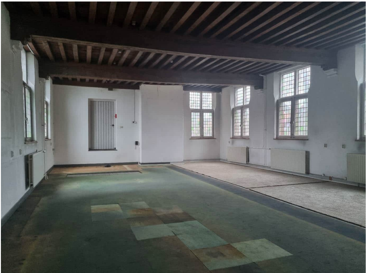
Ruimte 2.08, met zicht op doorgang naar ruimte 2.02
