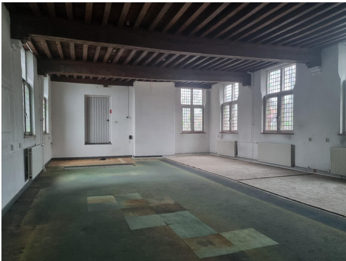
Ruimte 2.08, met zicht op doorgang naar ruimte 2.02
