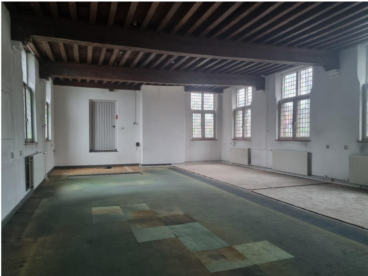
Ruimte 2.08, met zicht op doorgang naar ruimte 2.02
